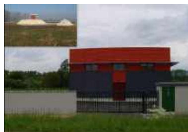
Forage n°2 et station de pompage de Troyon
