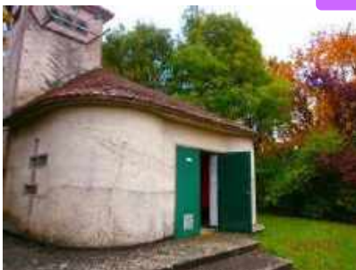
Forage de Tilly - Villers
