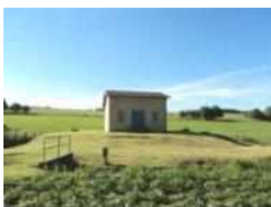
Station de pompage de Dompierre-aux-Bois
