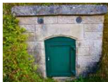
Captage source de Mexico Haute
