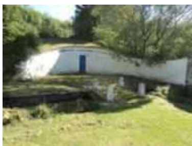
Galerie captant source de Deuxnouds-aux-Bois
