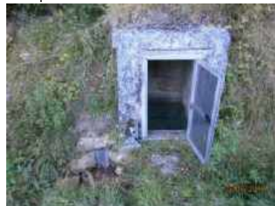
Captage source de la Côte du Frêne
